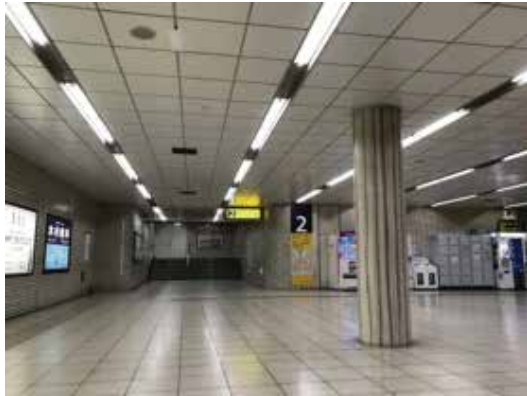
LED照明(赤坂駅)
