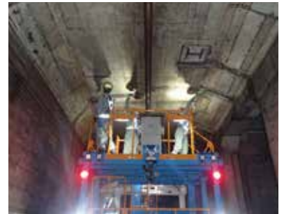
トンネル巡視
