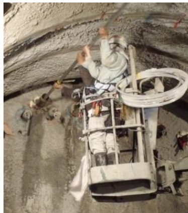
SAA設置状況写真
