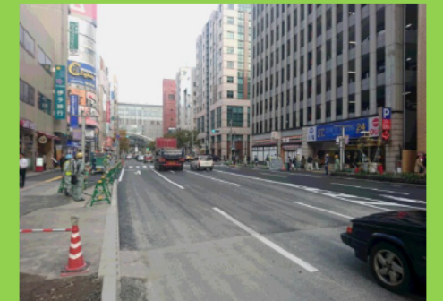
[道路の復旧完了] 11月15日(火)午前5時
