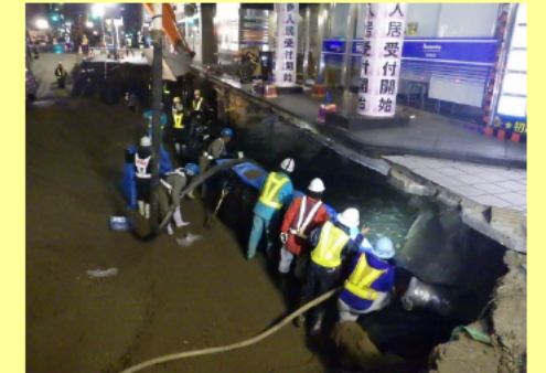
[近隣ビル基礎周辺の充填]
