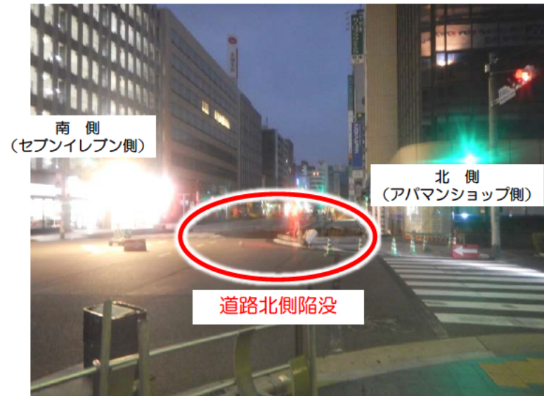
③ 5:30頃 道路北側陥没
