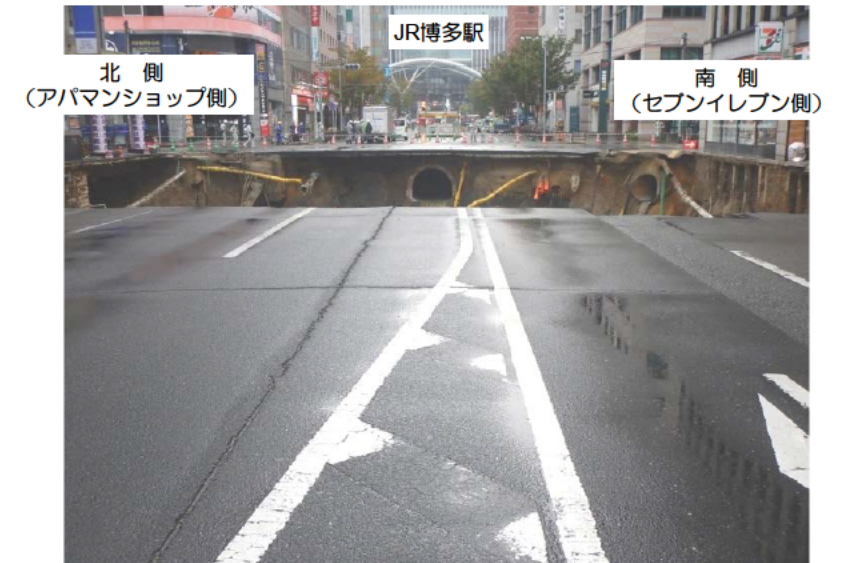
④ 7:20頃 道路中央部陥没
