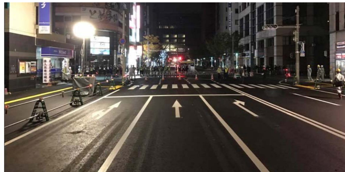
道路開放 (キャナルシティ側から博多駅側を望む)
