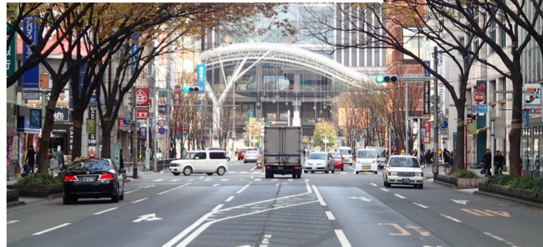
工事着手前のはかた駅前通り (キャナルシティ側から博多駅側を望む)
