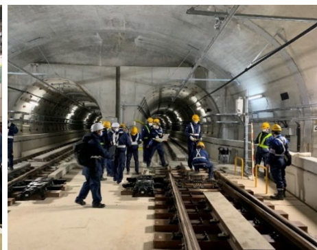
▲ 構築検査の様子
