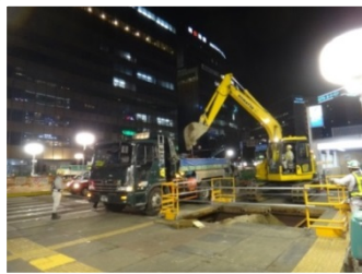
▲土砂積込状況(住吉通り)
