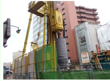
▲土留工の施工状況
