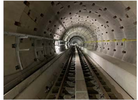
③ 軌道・電線路工事の状況 <シールド区間>
