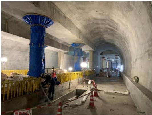
④ トンネルの構築状況 <ナトム区間>
