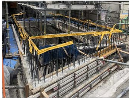
② 駅換気塔の建築状況 <地上部>
