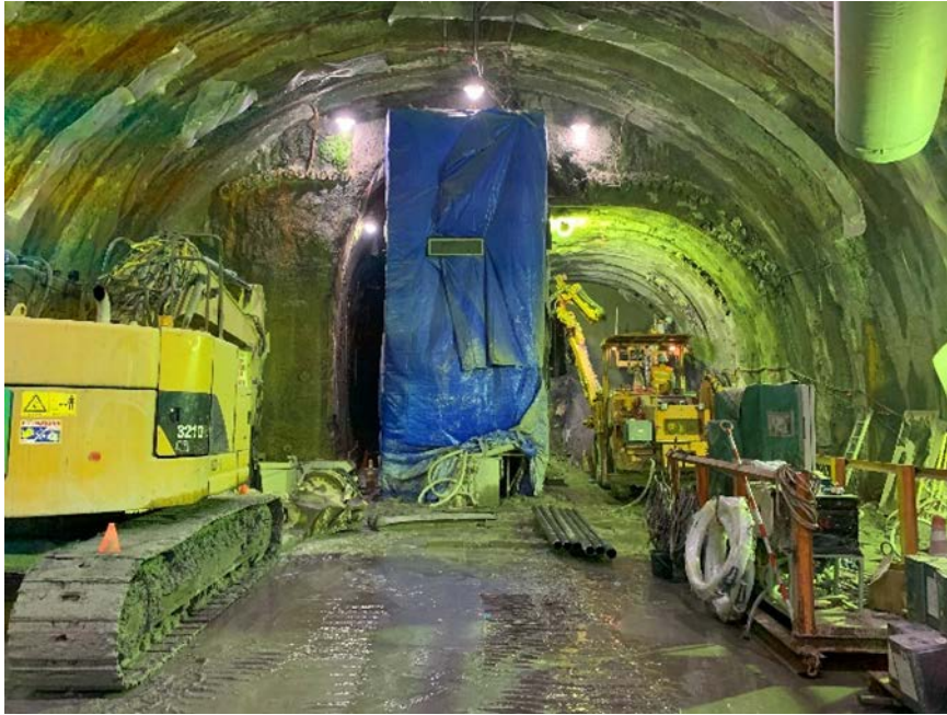
▲ 3連トンネル(右坑)の掘削状況
