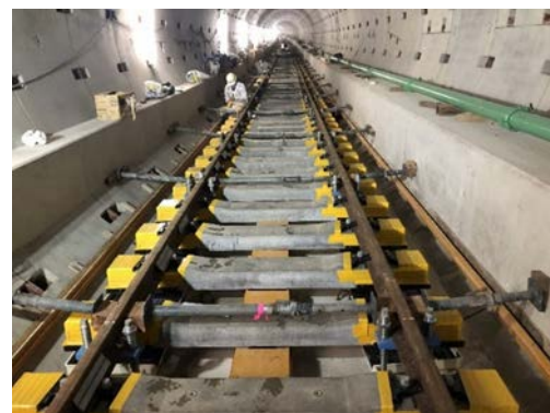
▲レール組立状況<天神南駅～中間駅(仮称)間>
