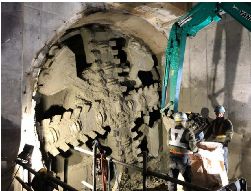
▲シールドマシンの到達状況<中間駅(仮称)>：地下4階 ※シールドマシンは、外殻を残して解体・撤去します。
