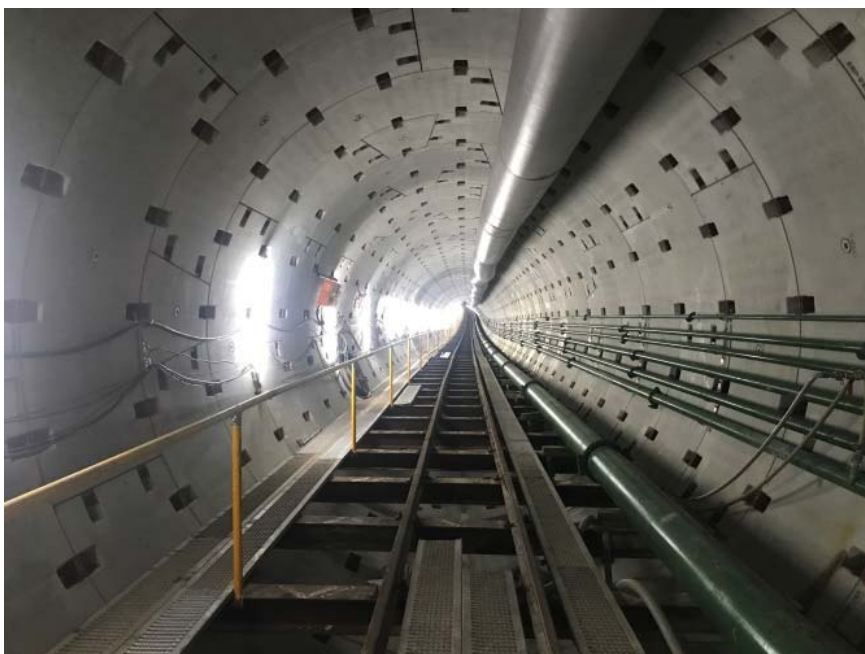
▲ 1本目の地下トンネル内（天神南駅方面から望む）
