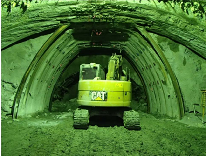
▲大断面トンネル部の掘削状況<右図の②部分>
