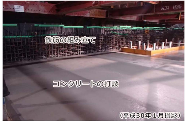
(平成30年1月撮影) <駅舎(地下1階)の構築状況>
