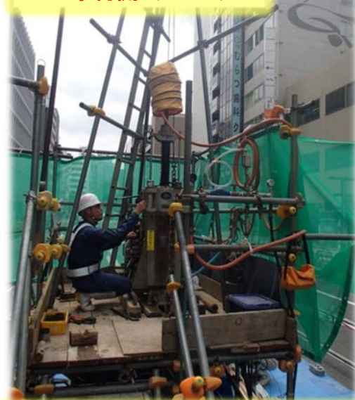
ナトム区間の地質調査(ボーリング状況)
