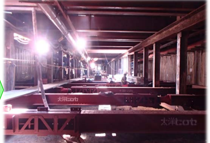
■左記写真(赤い点線部分)の地下の状況 地上から最大で4mの位置を掘削しています。
