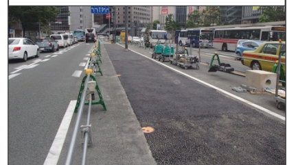
9月18日撮影 (中央分離帯等撤去状況)
