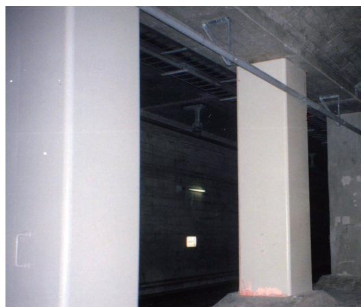
耐震補強後の中柱
