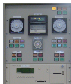
風速雨量警報装置
