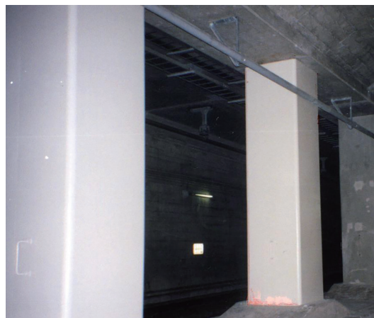
耐震補強後の中柱
