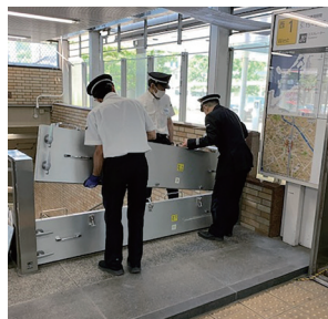
止水板設置訓練
