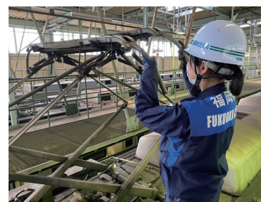
パンタグラフ点検
