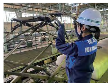
パンタグラフ点検
