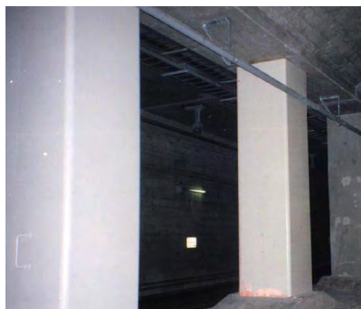
耐震補強後の中柱
