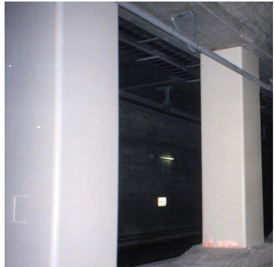
耐震補強後の中柱
