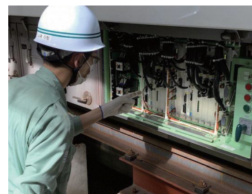
機器箱内点検
