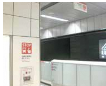
列車非常停止押しボタンと案内板
