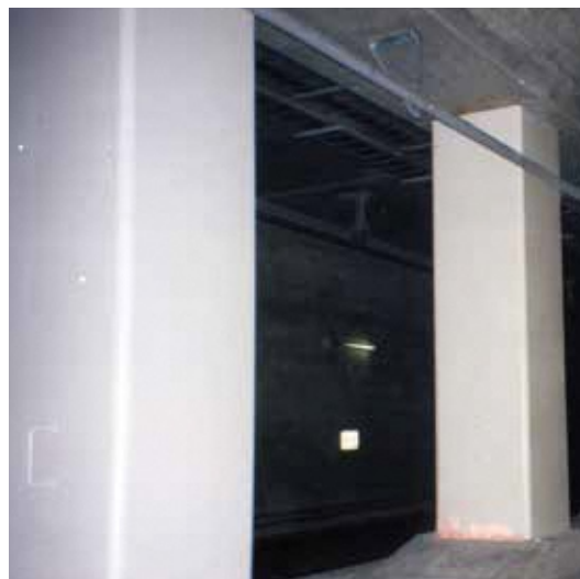
耐震補強後の中柱
