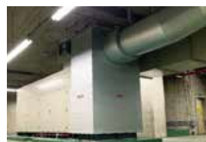
非常用発電機
