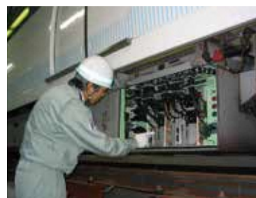
機器箱内点検
