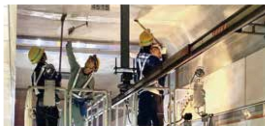
構造物打音検査
