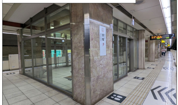
駅空調の改善 (赤坂駅クールルーム)
