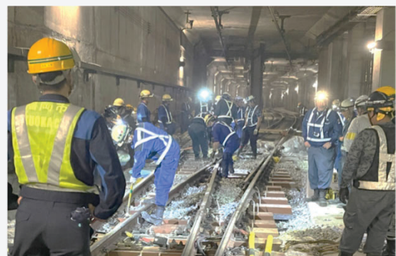
[参考] 夜間工事 (分岐器更新工事)
