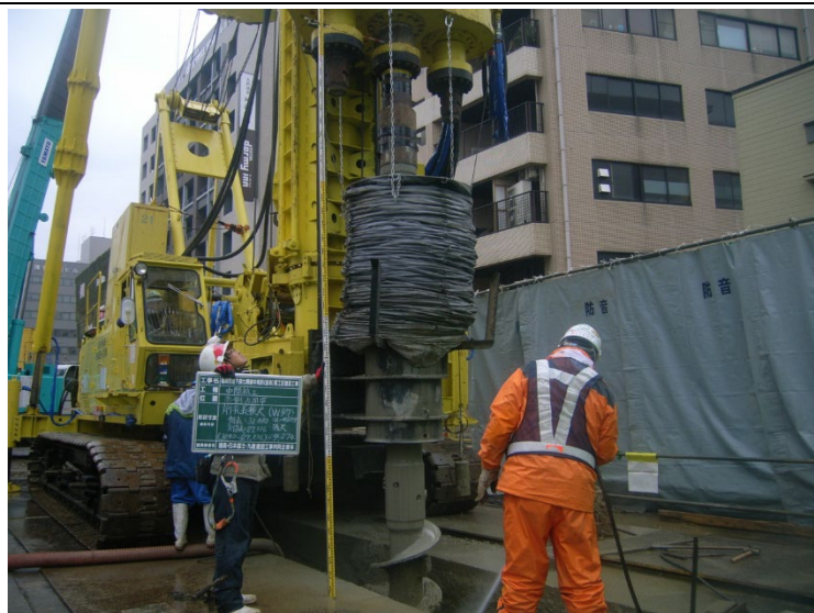
写真 9-1-5 環境保全措置の実施状況（防音シート等の設置）
