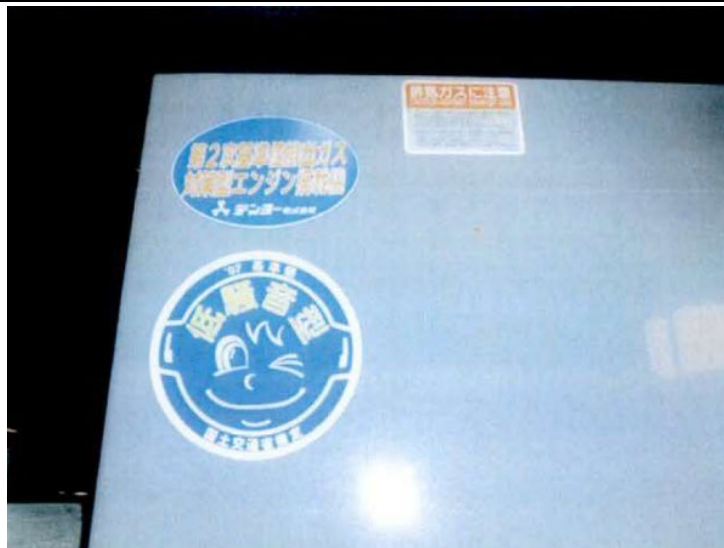
写真 9-1-4 環境保全措置の実施状況（発電機等の防音対策）
