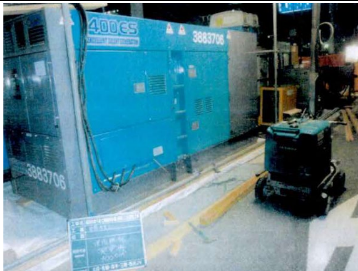
写真 9-1-3 環境保全措置の実施状況（発電機等の防音対策）
