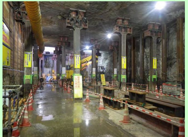
写真12 空港線連絡通路部の仮受状況(施工中)
