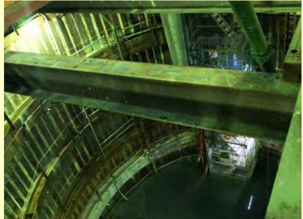
写真8 トンネル坑内の水抜き状況(立坑部)
