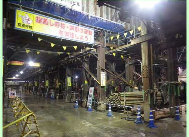
写真10 JR地下街下部の仮受状況(完了)
