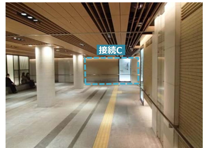
写真⑤ はかた駅前通り地下通路との接続
