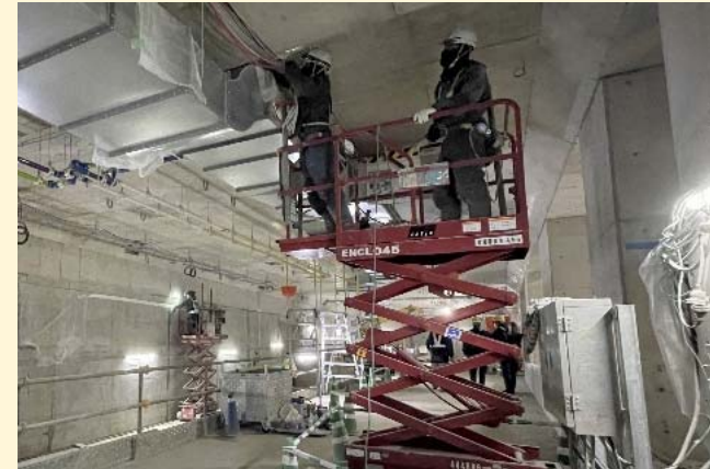
設備工事の進捗状況 (駅舎部：地下4階)
