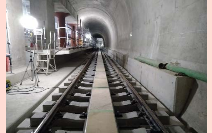
軌道工事の進捗状況 (博多駅付近)
