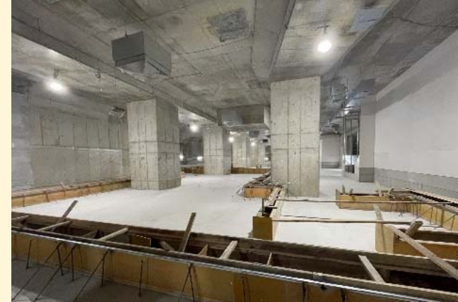
建築工事の進捗状況 (駅舎部：地下5階)
