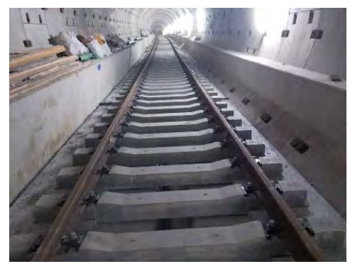
① 軌道工事・レール敷設 (東行)
