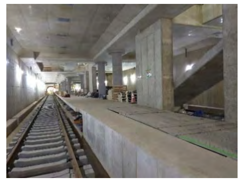
② プラットホーム
