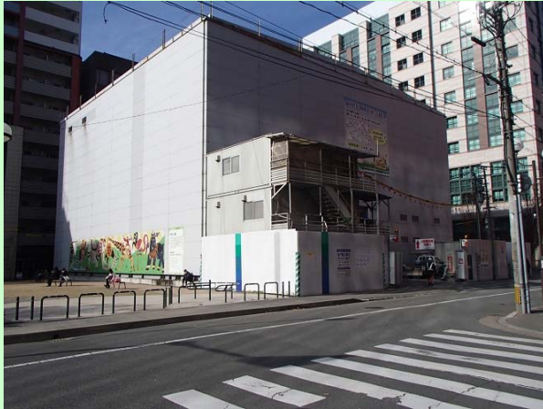
写真7 防音ハウス 〈明治公園内〉
