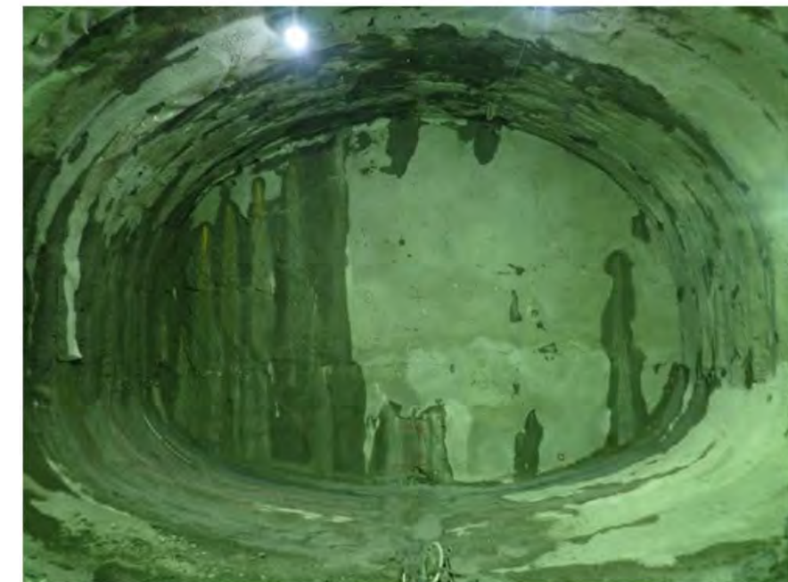
掘削完了 (9月26日)
