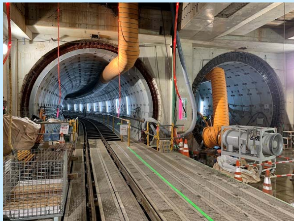
写真5 シールド掘進状況 〈中間駅西工区：西行線〉
