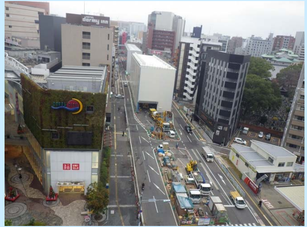
写真2 はかた駅前通りの占用状況 〈博多駅側より〉
