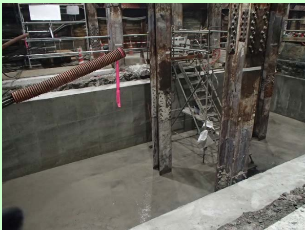
写真11 駅舎部の構築状況 〈アンダーピニング区間：JR地下街部〉
