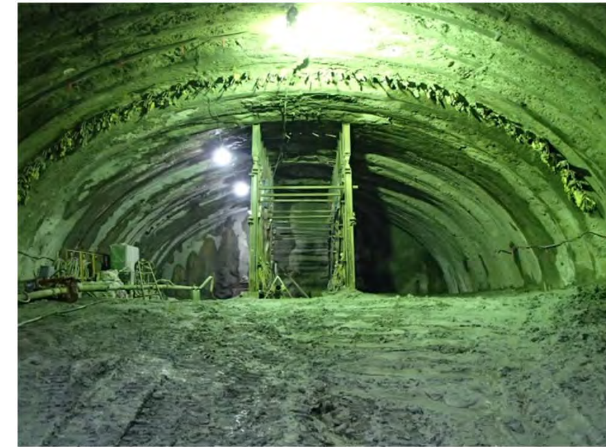
上半部掘削完了 (8月27日)
