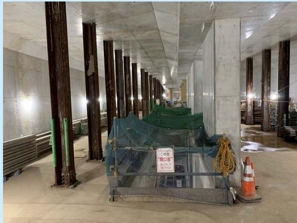
写真3 駅舎部の構築完了 〈中間駅西工区：地下2階〉
