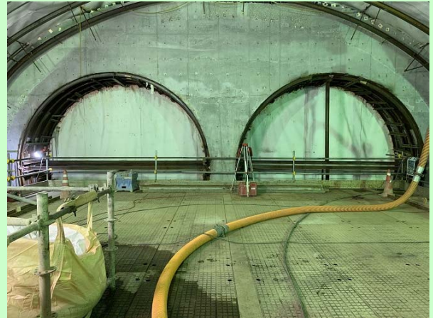
写真8 トンネル覆工状況 〈ナトム区間：大断面トンネル部〉
