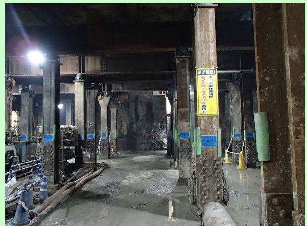
写真12 仮受・掘削状況 〈アンダーピニング区間：地下車路部〉
