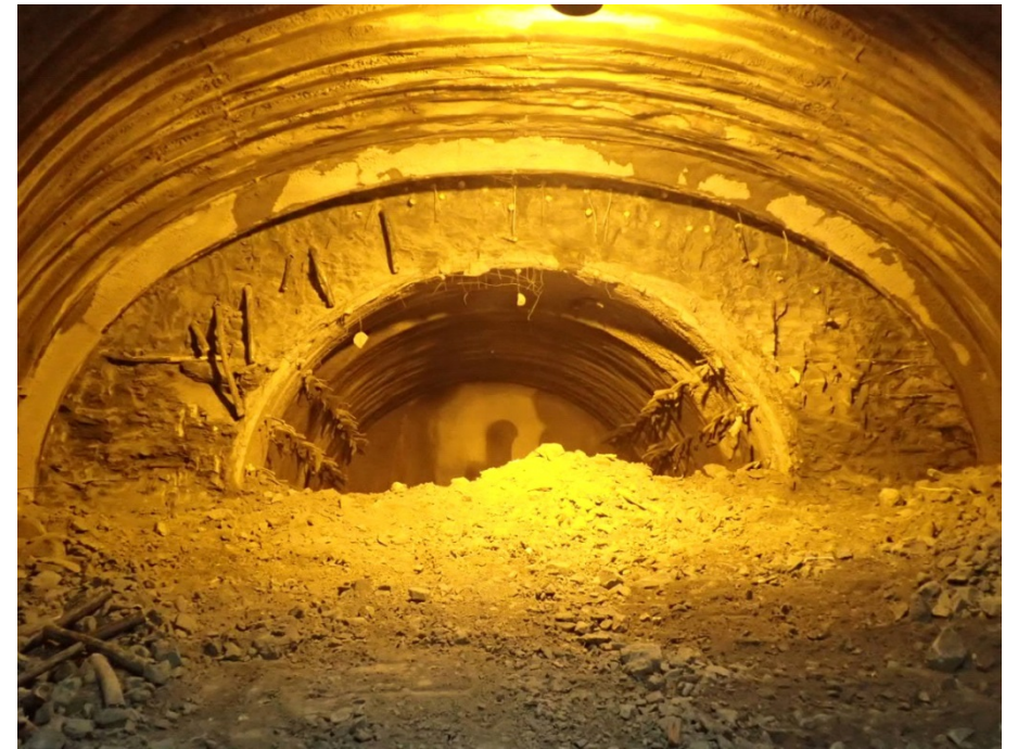
104基掘削完了写真(11月7日昼勤)
