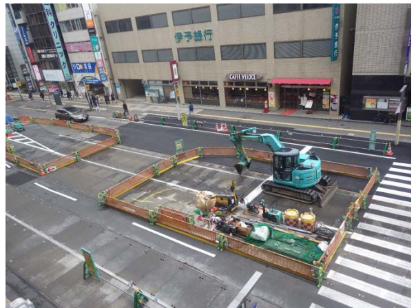
④覆工板の撤去状況
