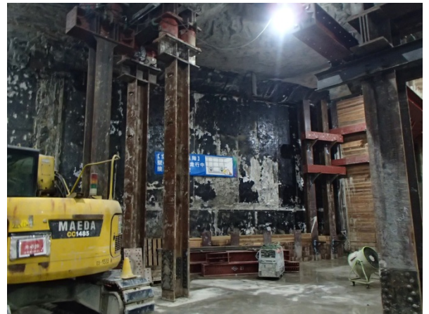
② 空港線連絡通路部の仮受状況
