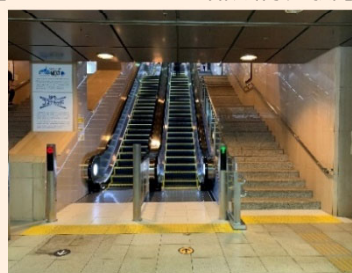
【エスカレーターの増設(博多駅)】
