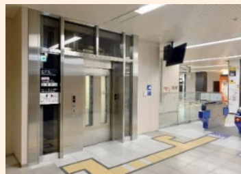
【エレベーターの増設（博多駅）】
