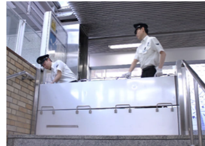
止水板取付の様子
