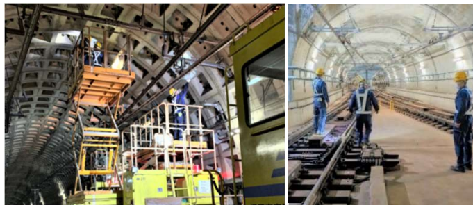
構造物検査（左） トンネル巡視（右）
