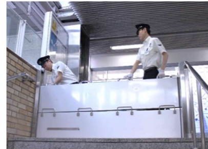
止水板取付の様子
