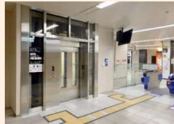
【エレベーターの増設（博多駅）】
