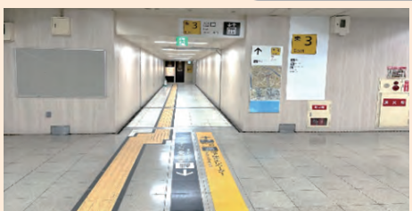
駅コンコース壁面改修後
