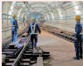
トンネル巡視
