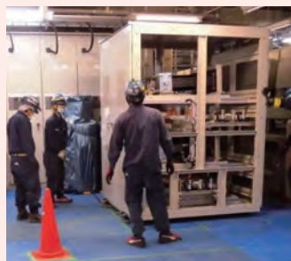
変電所設備更新(回生インバータ更新)
