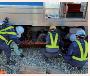
脱線復旧訓練（保守係員）
