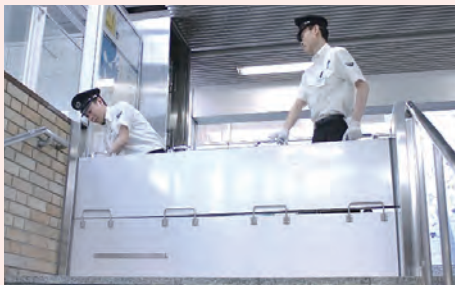
止水板設置訓練
