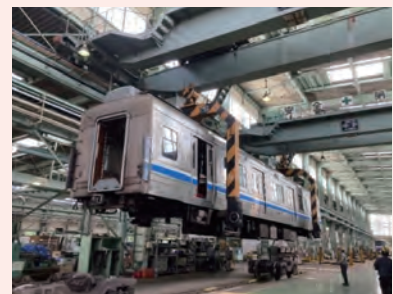
車両検修設備
