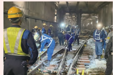
分岐器更新工事
