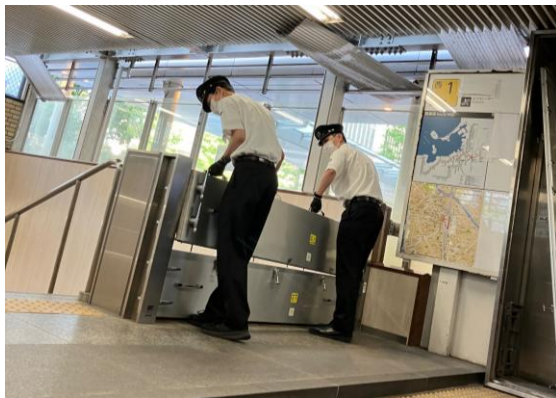
止水板設置の様子
