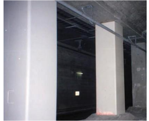
耐震補強後の中柱
