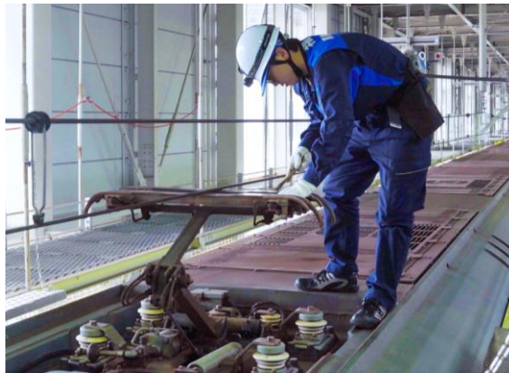
パンタグラフの点検
