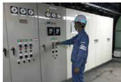
空調機器の日常点検
