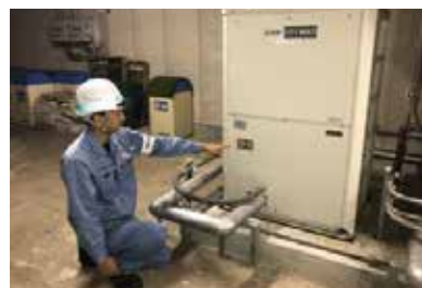
動力盤の日常点検
