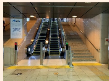
【エスカレーターの増設(博多駅)】
