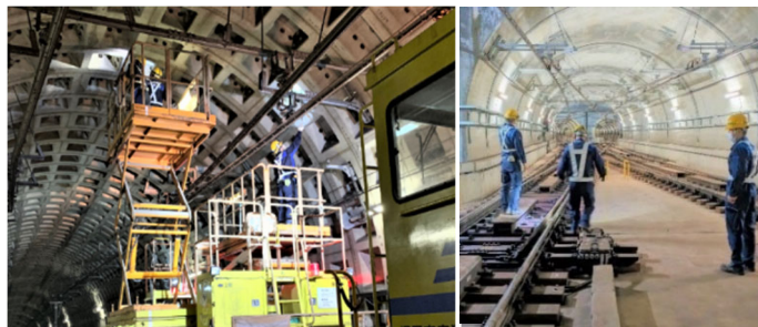
構造物検査（左） トンネル巡視（右）
