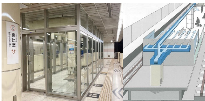
空港・箱崎線クールルーム（左） 七隈線スポット冷房イメージ（右）
