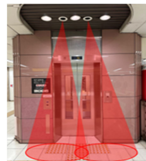
人感センサー付タッチレス自動運転エレベーター（※センサーはイメージ）
