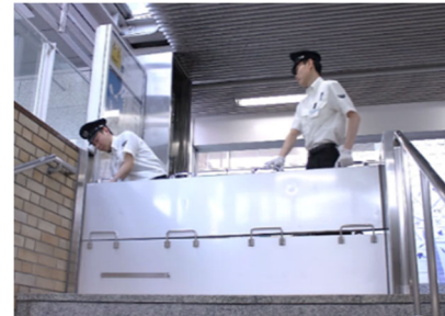
止水板取付の様子
