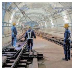
トンネル巡視
