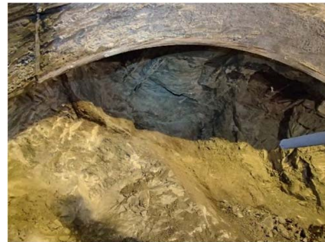
写真-1 中央坑No.265 (TD=83.0m付近) 天端小崩落発生状況 (平成28年1月26日発生)
