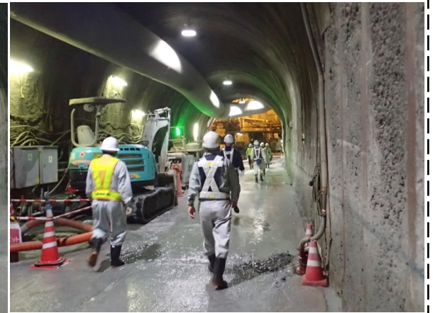
連絡坑～交差部
