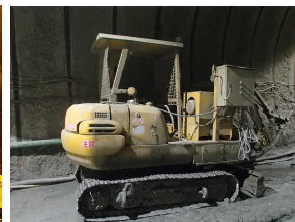
吹付けロボット
