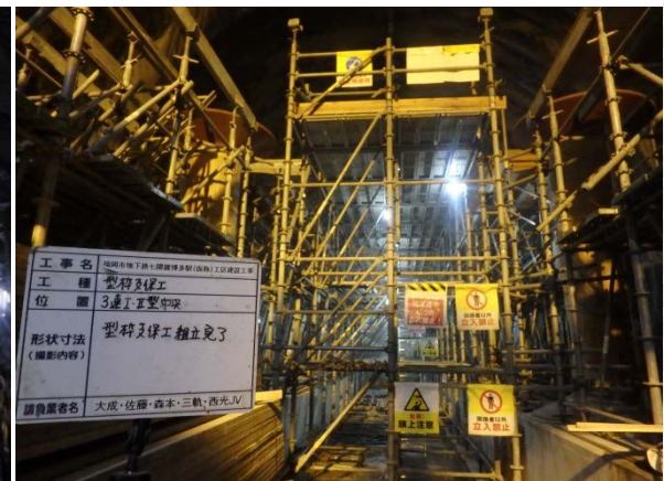
型枠支保工組立完了状況
