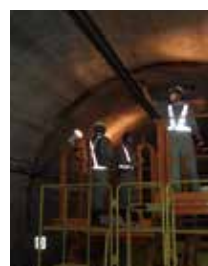
構造物打音検査
