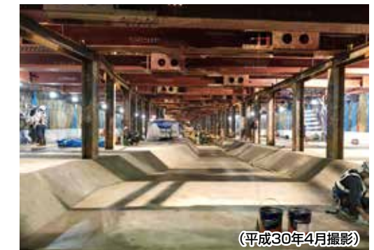
《駅舎部分の構築状況》
