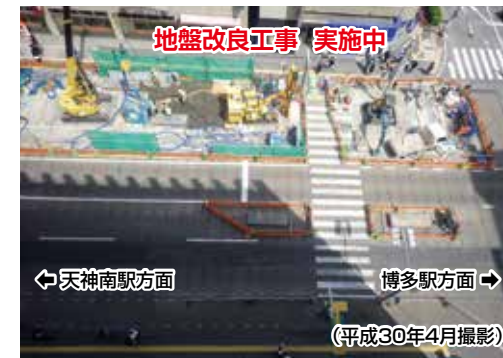
《地盤改良工事の施工状況》
