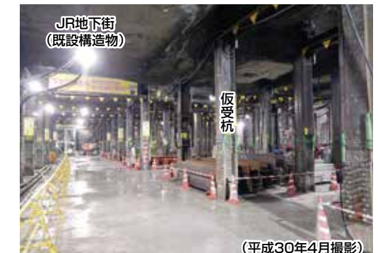
《博多駅前広場(地下)の施工状況》
