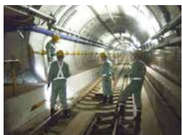
トンネル巡視
