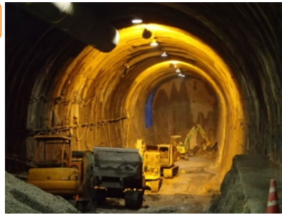
▲本坑の掘削状況
