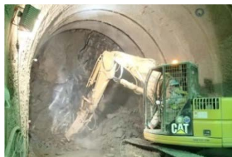
▲連絡坑の掘削状況
