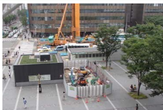
▲博多駅前広場の占用状況 (工事は夜間に行っています)
