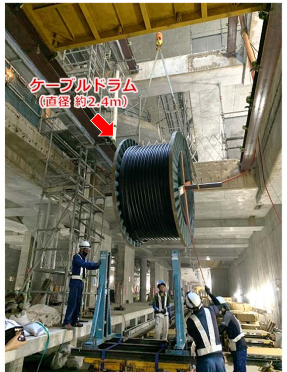
▲ 電気ケーブルの搬入状況 <櫛田神社前駅>
