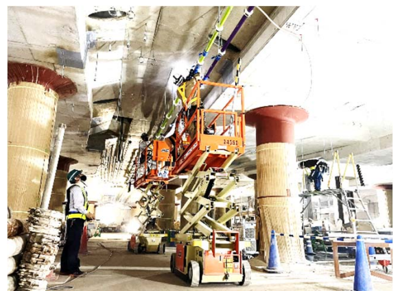
▲ 設備配管の敷設状況 <博多駅>
