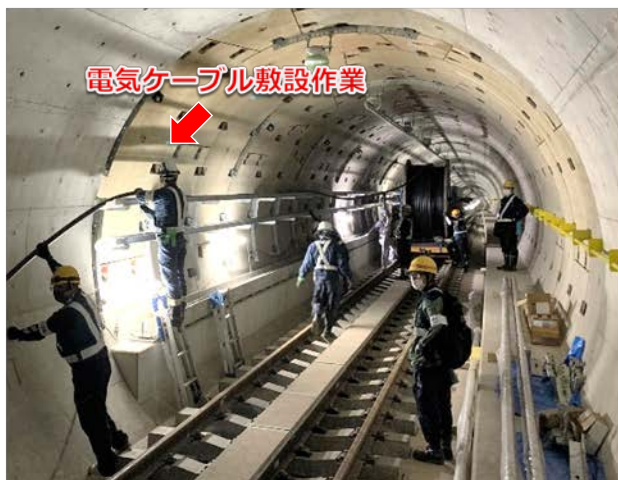
▲ 電気ケーブル敷設状況 <シールド区間>
