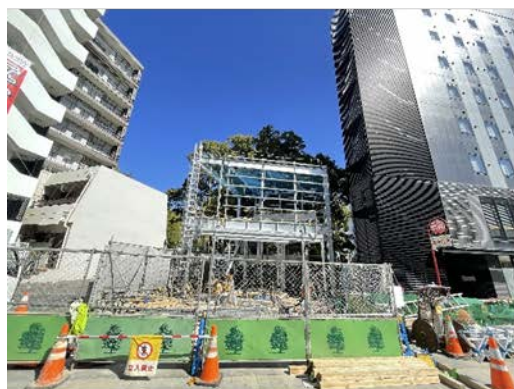
▲ 出入口上屋の鉄骨建方状況 <櫛田神社前駅>
