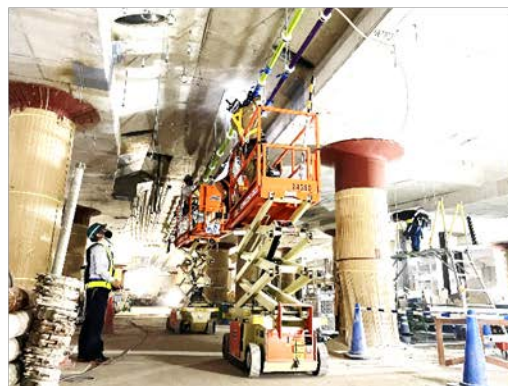
▲ 設備配管の敷設状況 <博多駅>
