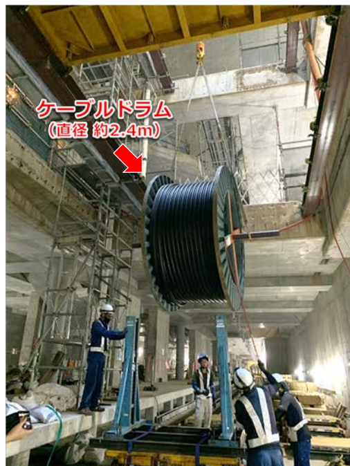
▲ 電気ケーブルの搬入状況 <櫛田神社前駅>
