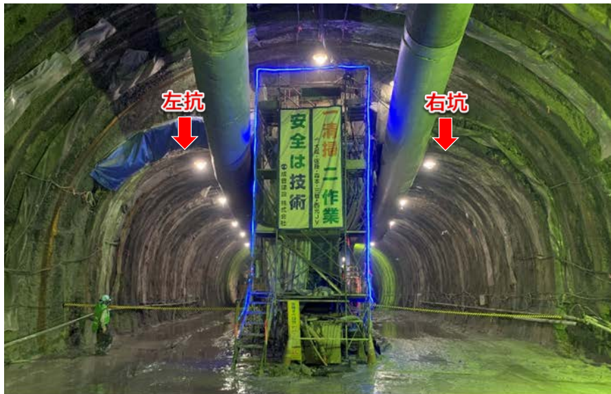
【写真③】 3連トンネル(左右坑)の掘削状況
