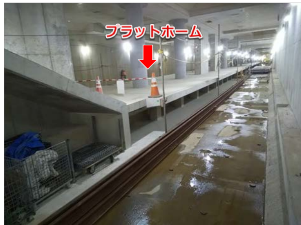
【写真②】プラットホームの構築状況 < 中間駅(仮称) 西工区：天神南駅方面より撮影 >
