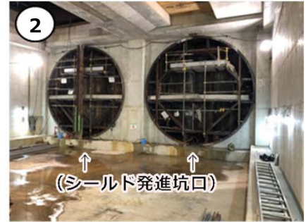
<地下4階の構築完了>
