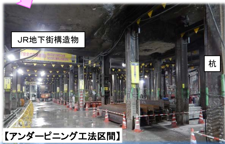
【アンダーピニング工法区間】 ■JR地下街の下で、構造物を杭で支えながら、掘削工事を行っています。(H29.11月時点)
