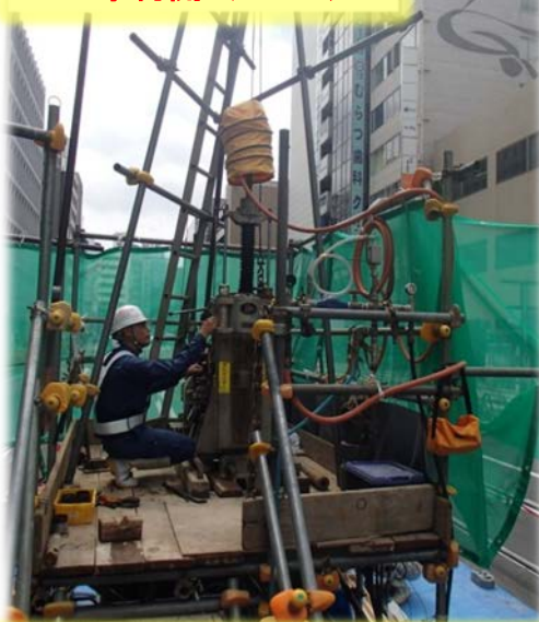
ナトム区間の地質調査(ボーリング状況)
