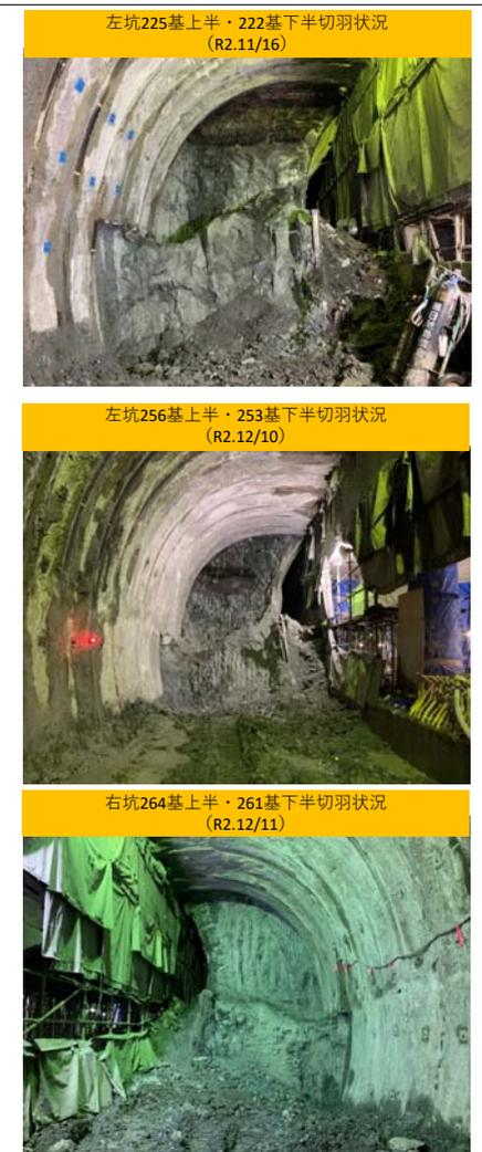
※土質や計測結果の状況に応じて適宜パターンを見直したが、その際にはより安全なパターンを選定しており、掘削後半では上記の3m補助ベンチ付全断面掘削を採用した。
