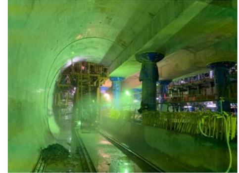
左右坑インバートコンクリート施工状況
