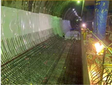
左坑覆工鉄筋施工状況
