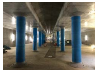
③ 駅舎構築(地下1階)
