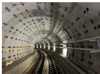
① 軌道工事・電線路工事(東行)
