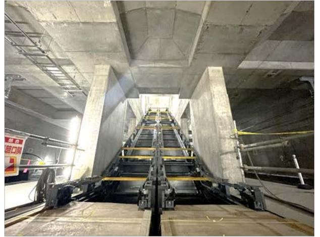
駅舎部の地下では、電線路工事や建築・設備工事及び昇降機工事を進めています。
