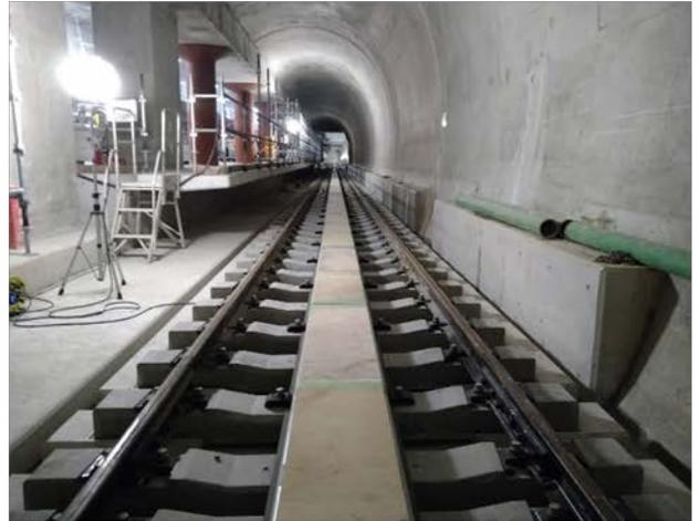
連絡坑トンネル部の構築が完了するとともに、標準トンネル部や3連トンネル部では、リアクションプレート設置や、信号ケーブル用のレール削孔などの軌道工事を進めています。
