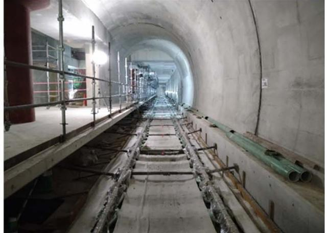
連絡坑トンネル部の構築を進めるとともに、標準トンネル部や3連トンネル部では分岐器など軌道敷設工事を進めています。
