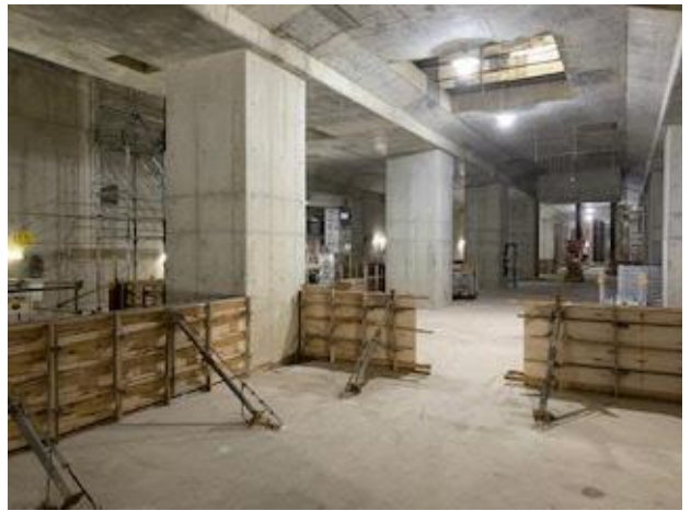
④建築・設備工事の進捗状況 (駅舎部：地下5階)
