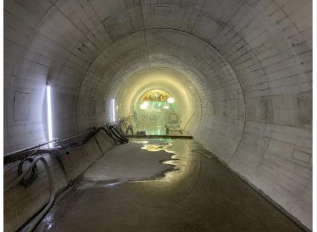
④軌道工事の進捗状況 (標準トンネル部〔レールガス圧接〕)
