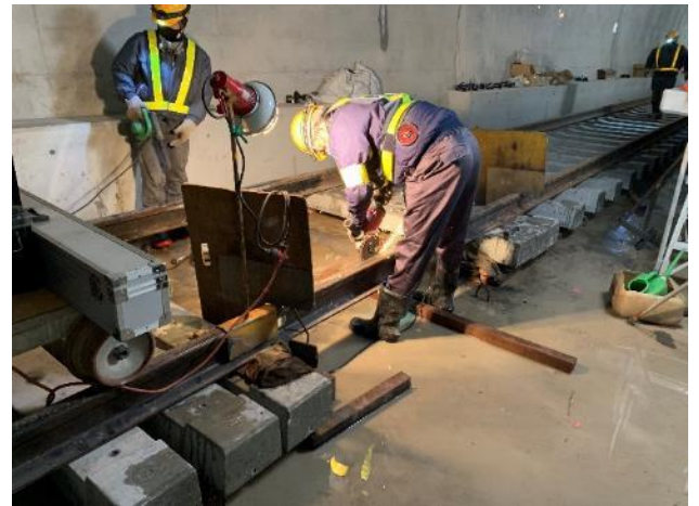
④軌道工事の進捗状況 (標準トンネル部〔レールガス圧接〕)
