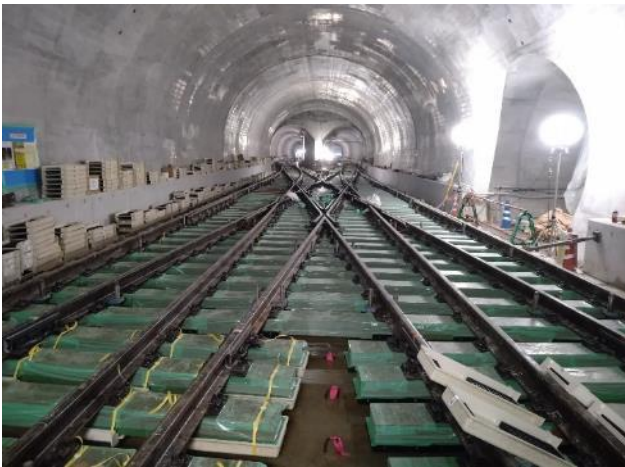
③軌道工事の進捗状況 (標準トンネル部〔分岐器〕)
