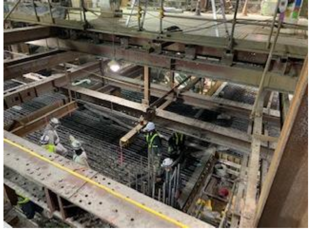
②駅舎部の構築状況 (北側開削部：地下1階)
