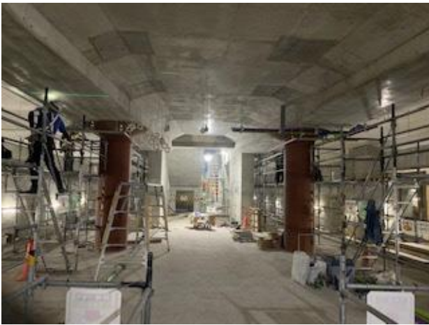
③建築・設備工事の進捗状況 (駅舎部：プラットホーム)
